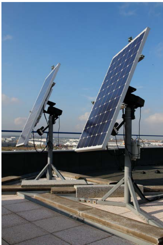
Obrázek I - Pohled na dvojici fotovoltaických stanic se systémem sledování slunce
