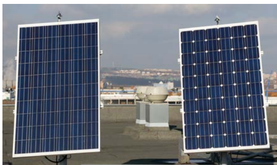
Obrázek II - Vlevo polykrystalický panel, vpravo monokrystalický panel
