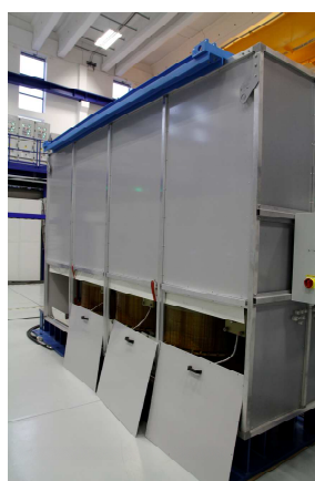
Obr. 3 Pasivní část – transformátor 22/0,4 kV 1,35 MVA pro připojení k distribuční síti
