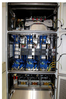
Obr. 2 Výzbroj skříně s výkonovými měniči – soustava základních stavebních bloků 150 kVA
