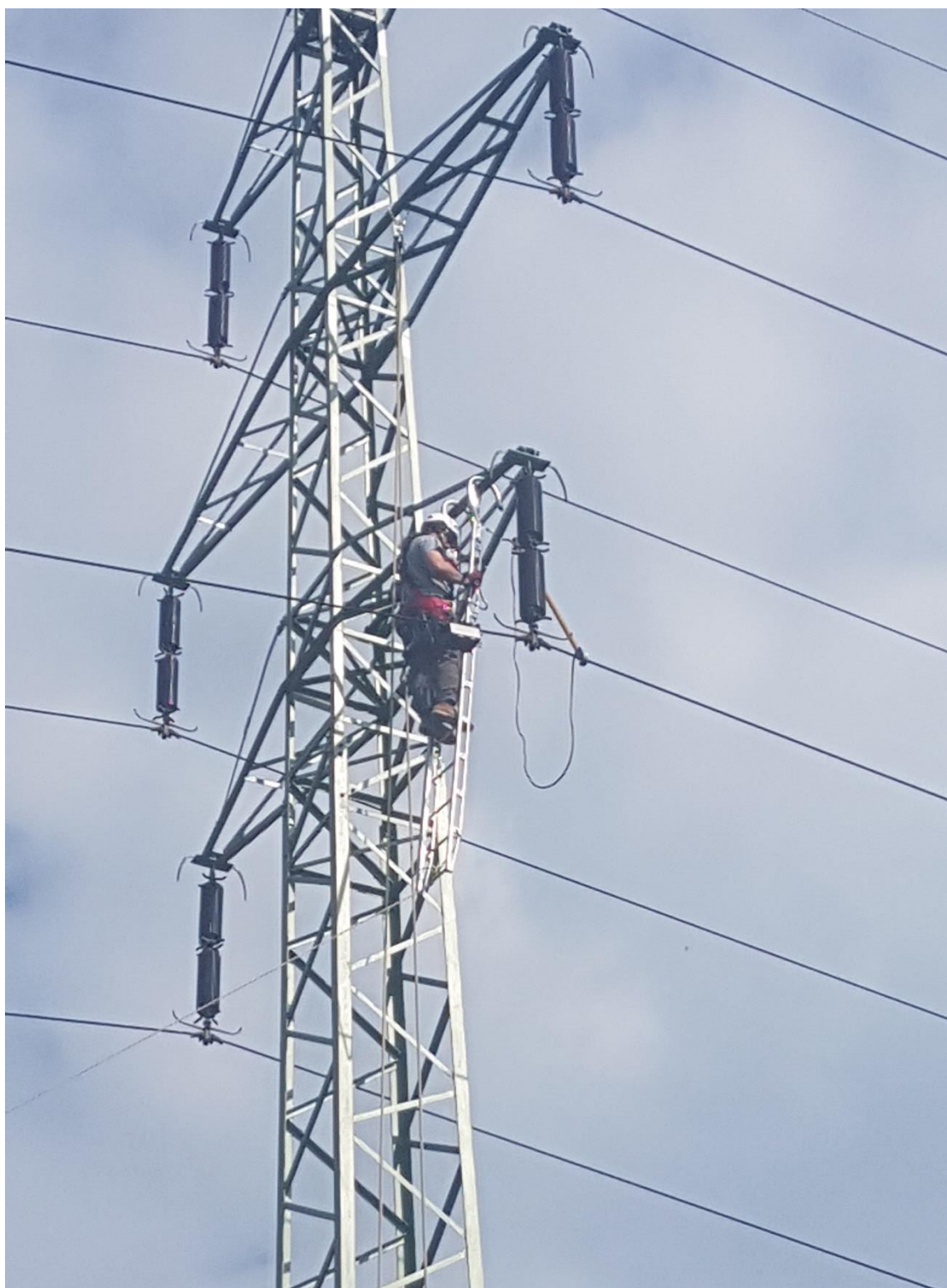
Obr. 22 Instalace měřicí stanice na 110kV vedení u obce Oplot
