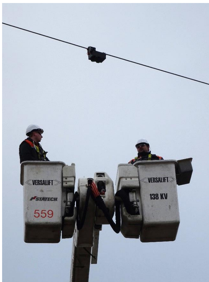
Obr. 17 Fotografie zachycující umístění měřicí platformy na vedení 22 kV
