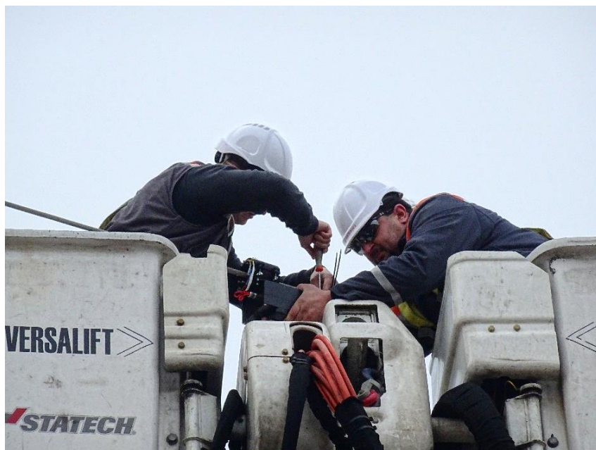
Obr. 16 Průběh instalace měřicí platformy na vedení 22 kV
