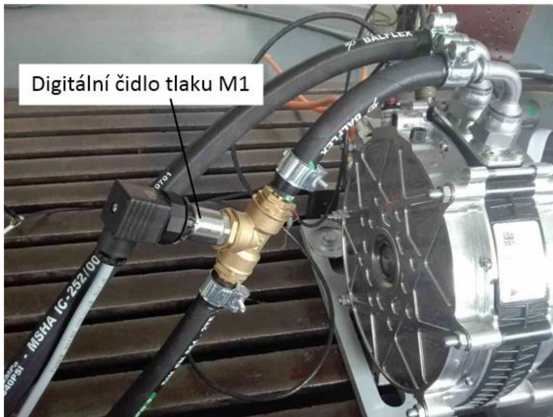
Obr. 3.3: Foto chladicího okruhu, 2. část
