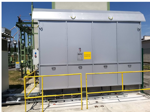
Speciální kompenzační transformátor 22/0,4 kV pro přenos točivé i netočivé složky v distribuční síti vn.
