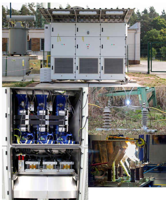
Zařízení pro kompenzaci 1,35 MVA
