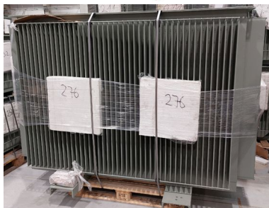
Optimalizovaný kompenzační transformátor 22/0,4 kV
