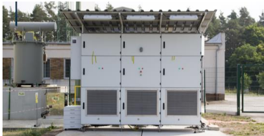
Zařízení pro kompenzaci zemních poruch
