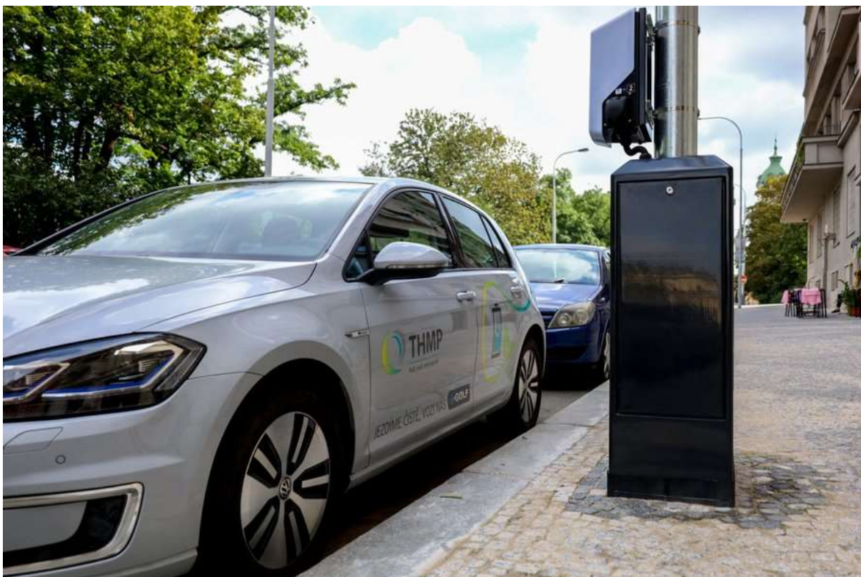
Obr. 6.1 Příklad testování nabíjecích wallboxů do lamp veřejného osvětlení
